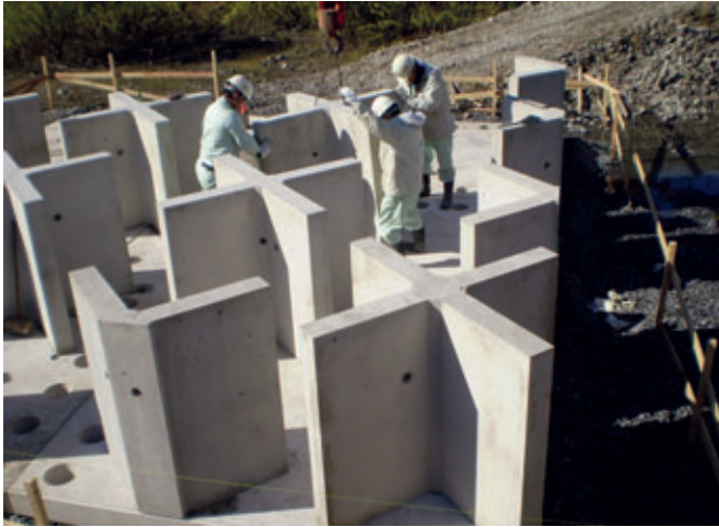
Figuras 5 e 6: Montagem do reservatório de águas pluviais em forma de X
