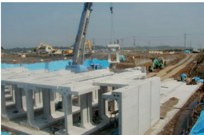
Fig. 2 e 3: Montagem na obra
